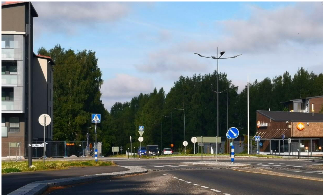
Kuva 7. Kangasalantien ja Vatialantien korotettu kiertoliittymä.
